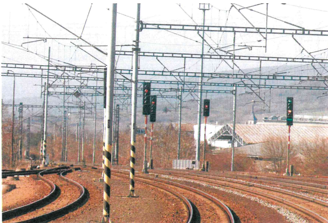
Fotografia č. 11: Prekrývanie odchodového návěstidla L5 stožiarom brány trolejového vedenia č.37, fotografované v km polohe 18,754, ŽST Pezinok, 19.3.2025
