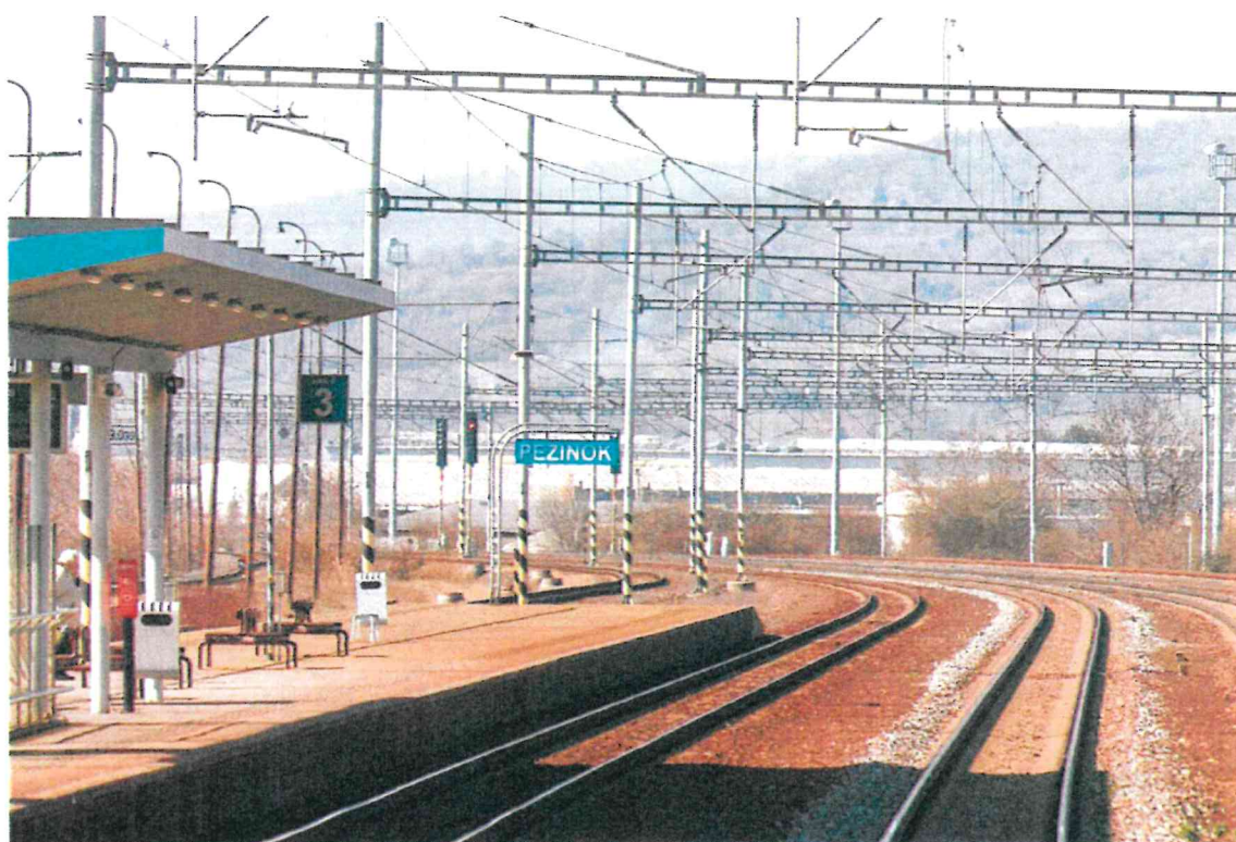
Fotografia č. 13: Prekrývanie odchodového návestidla L4 tabuľou označujúcou názov dopravného bodu pri jazde po dopravnej koľaji č. 1, ŽST Pezinok, 19.3.2025
