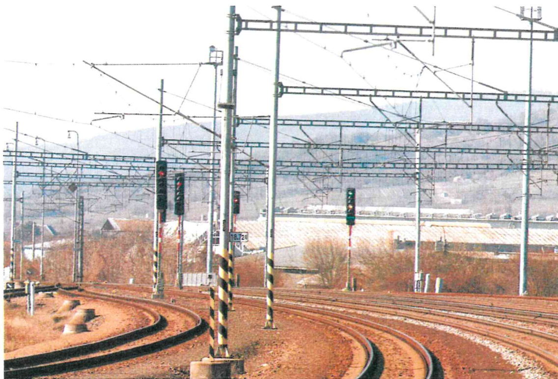
Fotografia č. 9: Prekrývanie odchodového návěstidla L1 odchodovým návěstidlom L5, fotografované v približnej vzdialenosti 400m od odchodového návěstidla L1 (oblasť dohľadnosti návěstidla L1 z 1.koľaje), ŽST Pezinok, 19.3.2025
