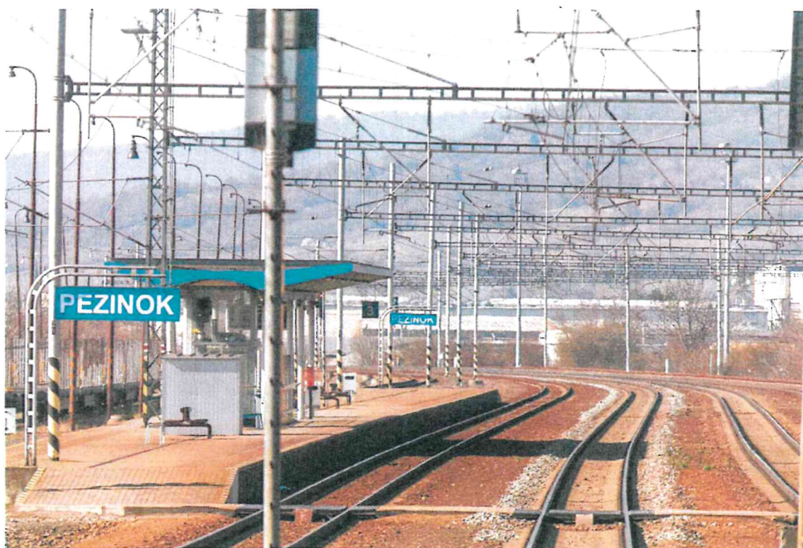
Fotografia č. 12: Prekrývanie odchodového návestidla L4 tabuľou označujúcou názov dopravného bodu pri jazde po dopravnej koľaji č. 1, fotografované v km polohe 19,355, ŽST Pezinok, 19.3.2025
