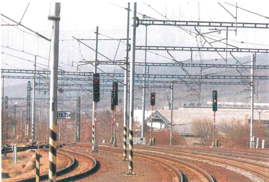
Fotografia č. 10: Prekrývanie odchodového návěstidla L1 odchodovým návěstidlom L3, fotografované v km polohe 18,783 (oblasť dohľadnosti návěstidla L1 z 1.koľaje), ŽST Pezinok, 19.3.2025
